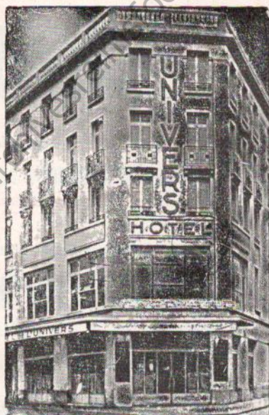
GD HOTEL DE L'UNIVERS 41, BOULEVARD FOCH (face Gare) REIMS - Tél. 47-52-71
